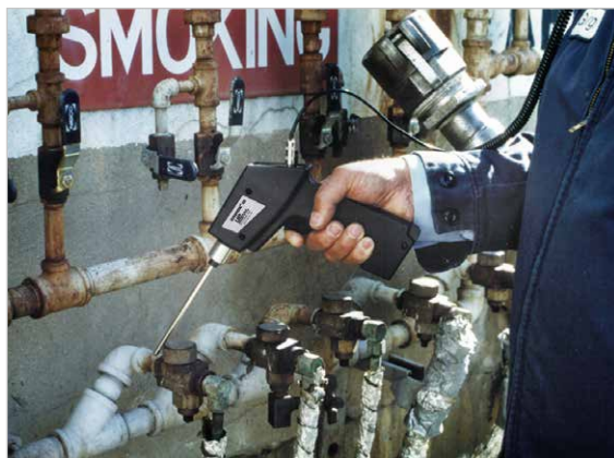
Teste purgadores de vapor
